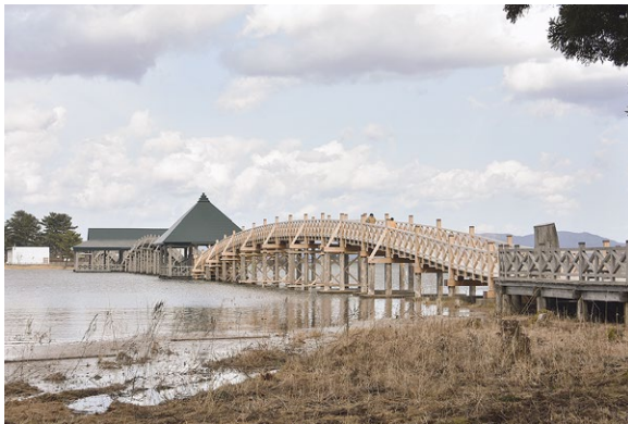
4月に通行可能となった鶴の舞橋
