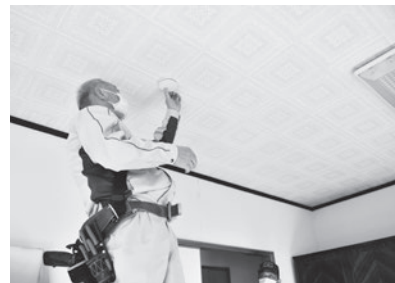
住宅用火災警報器を設置するようす
