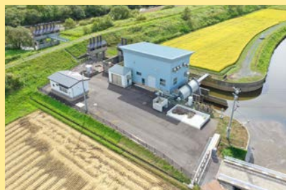
▲三好排水機場
