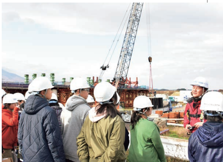
△保安橋の架け替え工事を見学をする子どもたち
