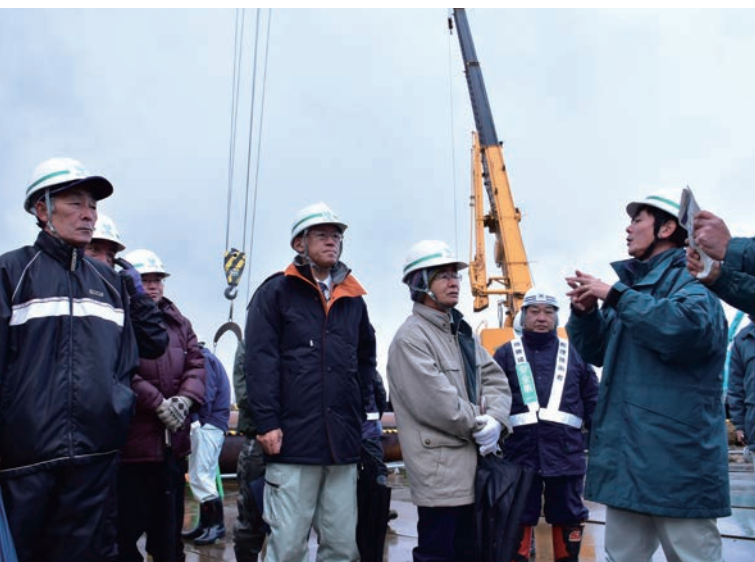
△改修工事現場を視察する自主防災組織の代表者と相川町長
