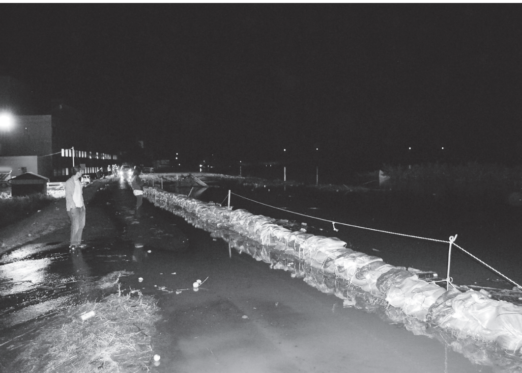
△9月16日（月）夜の役場裏の土手。岩木川が増水し、堤防を越水したため、土のうを積み対応
