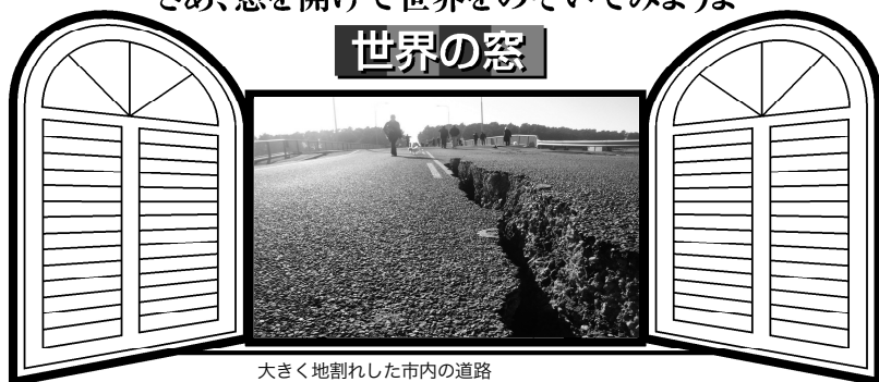
大きく地割れした市内の道路
