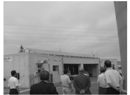
・「循環センター」屋根の太陽光発電パネル
