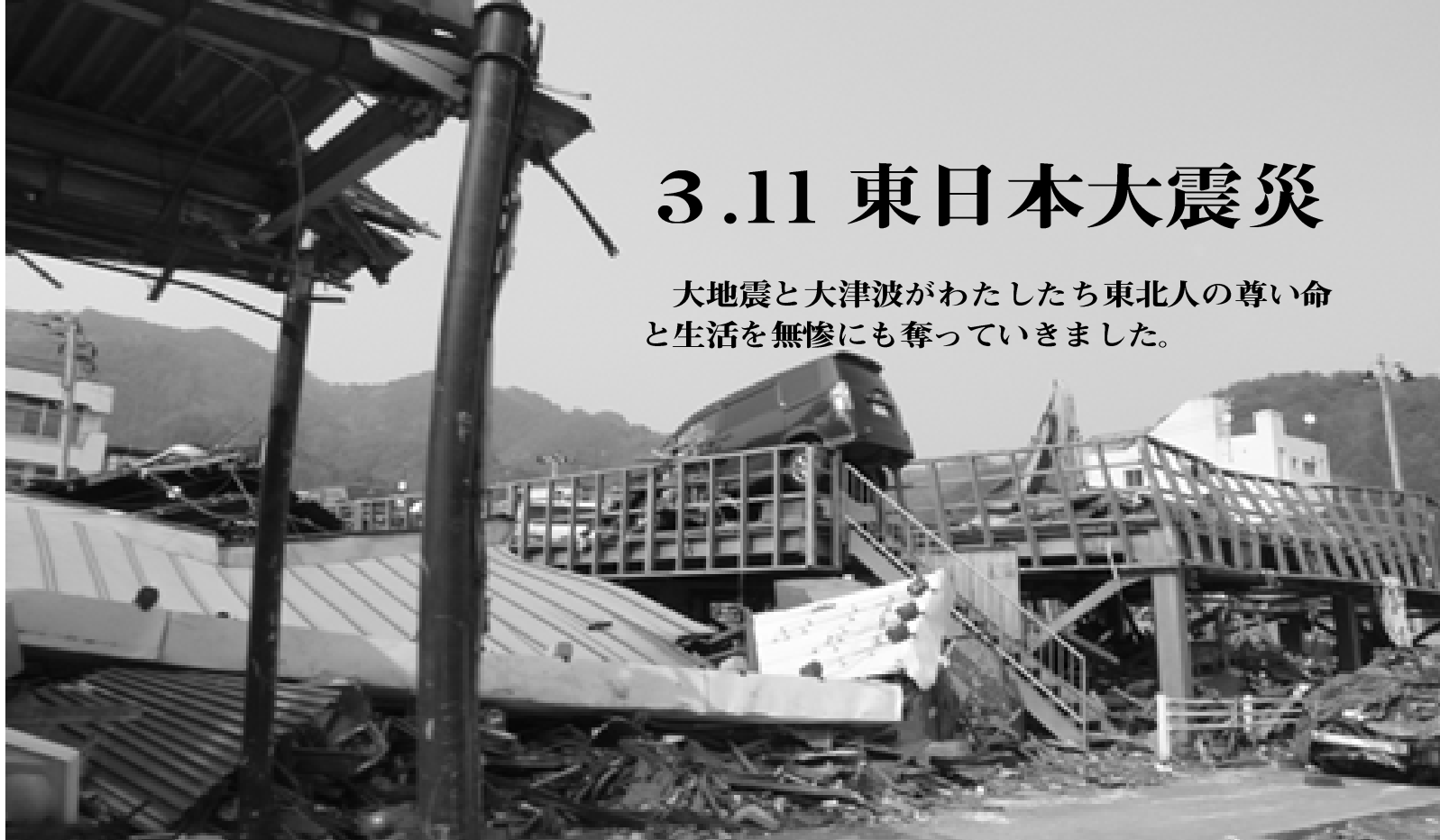
△津波により瓦礫の山になった街（岩手県釜石市内4月14日撮影）
