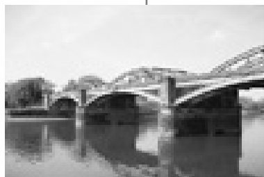
・Barnes Railway Bridge / バーンズ鉄道橋 1849年に作られた電車と歩行者の橋。
