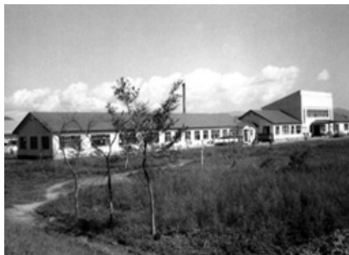
△旧町立中央病院（昭和34年）
