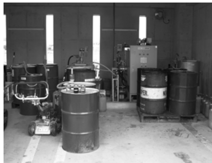
▲BDF製造設備
