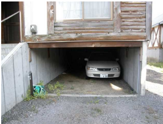
【みどり第2団地の駐車場】
