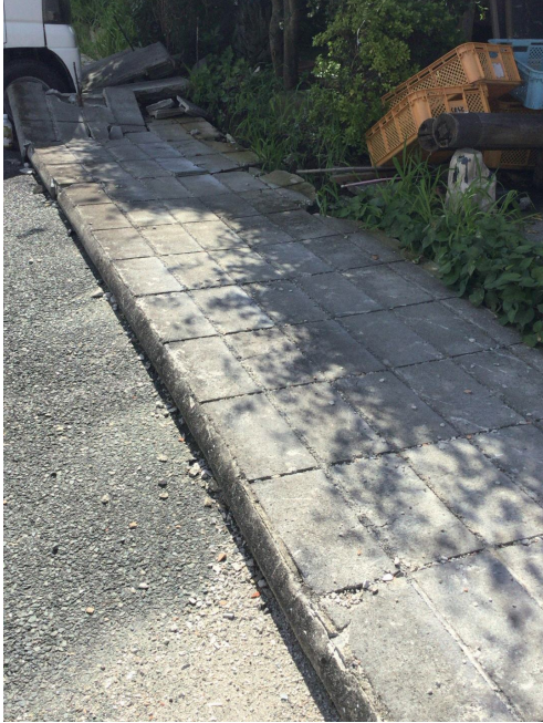
地震によりブロック塀が倒壊
